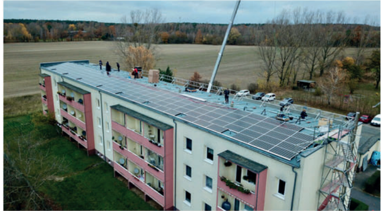
Bild 6: Viel Photovoltaik hilft viel: Nahezu die gesamte Dachfläche des Mietwohnhauses wurde mit Aleo-Modulen aus deutscher Produktion eingedeckt
