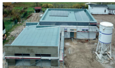
Bild 5: Die auf dem Flachdach des Neubaus aufgeständerten PV-Module befinden sich hinter einer Attika, sie sind von unten aus nicht zu sehen
