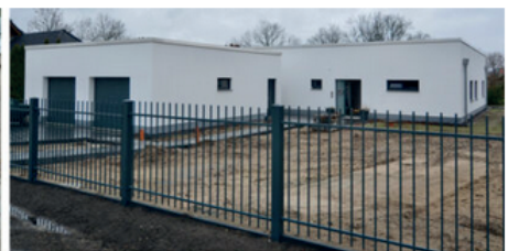
Bild 5: Die auf dem Flachdach des Neubaus aufgeständerten PV-Module befinden sich hinter einer Attika, sie sind von unten aus nicht zu sehen
